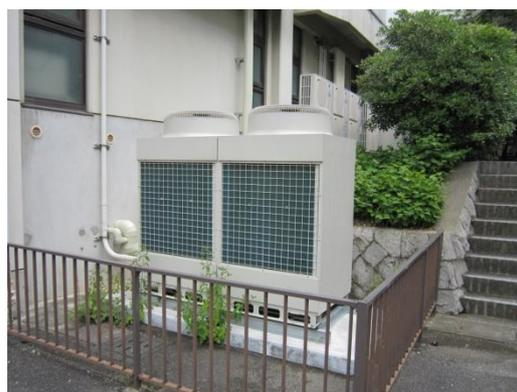
図6 電算機室用空調室外機
